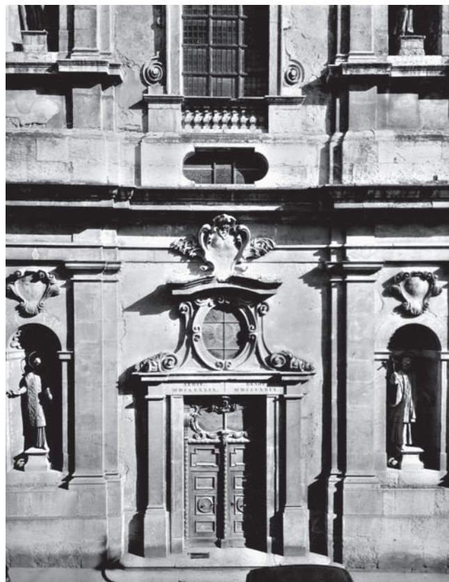
Abb. 5 a Fassade der Jesuitenkirche Solothurn im schadhafte Zustand vor der Restaurierung von 1936. Über dem Portaloblicht hängt, vor der Stifterinschrift am Gebälk, die Kartusche mit dem im April 1798 entfernten Wappen König Ludwigs XIV. Über den seitlichen Figurennischen finden sich die Kartuschen mit den geblendeten Wappen des Ambassadorspaars de Gravel. Fotografie von Edgar Schlatter.
